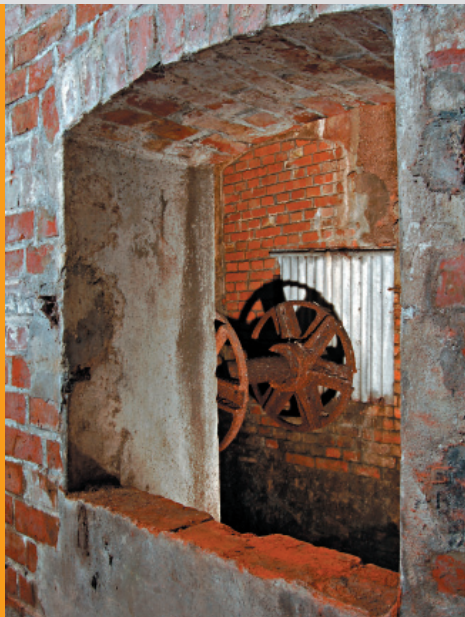
Am Tag des offenen Denkmals wurde erstmals der frühere Mühlenbereich auf dem Museumsgelände zugänglich gemacht. Hier ist die original erhaltene Radkammer der Mühle zu sehen. Die erste Färberei auf dem heutigen Museumsgelände wurde wahrscheinlich noch mit dem Wasserrad angetrieben.
