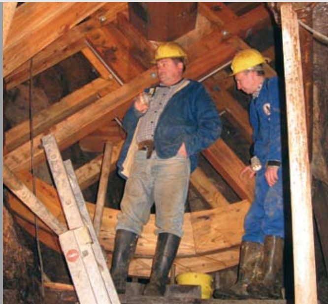
Einbau des nach historischen Vorbildern rekonstruierten Wasserrads im Heinzenschacht
