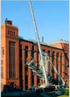
Aufstellen des Zugangsturmes für den Fabrik-Erlebnisrundgang
