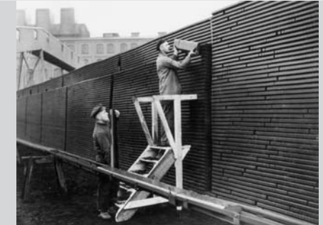
Fotografie aus der Sonderausstellung „Ein Kohlestein wird 150“: „Kohlestapler der Brikettfabrik“
