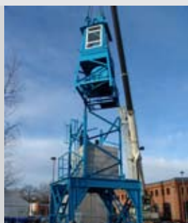
Die Kabine des Turmdrehkrans wird aufgesetzt.
