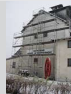
Einbau neuer Fenster im Museumsgebäude
