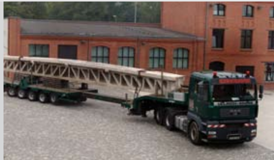
Ankunft des Betonträgers der Chemnitzüberdeckung, die anlässlich der ökologischen Aufwertung des Flusslaufes am Falkeplatz 2009 zurückgebaut wurde.
