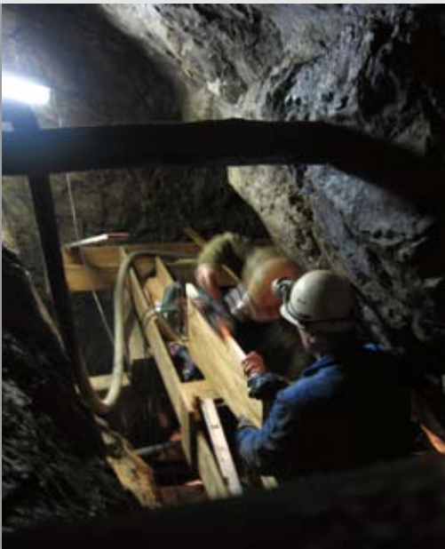
Ausbau Schauort „Alexanderspat“
