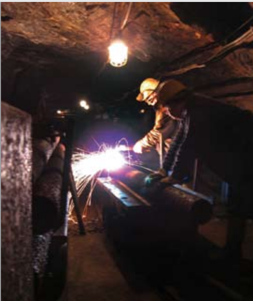
Ausbau Schauort „Alexanderspat“
