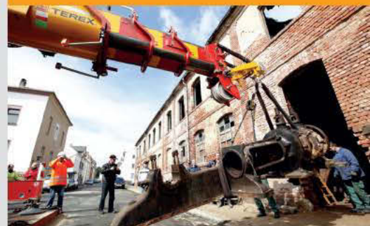
Transport der Dampfmaschinenteile von der Petersstraße in die Tuchfabrik Gebr. Pfau
