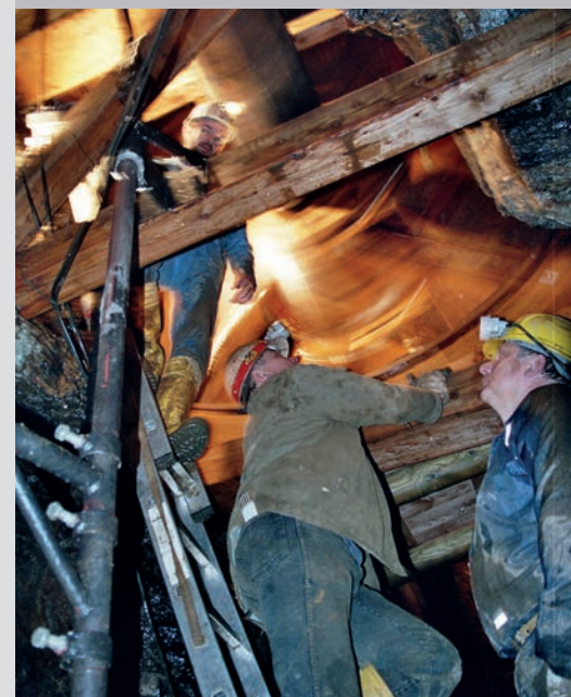
Mitarbeiter bei Rekonstruktionsarbeiten an der Ehrenfriedersdorfer Radpumpe.
