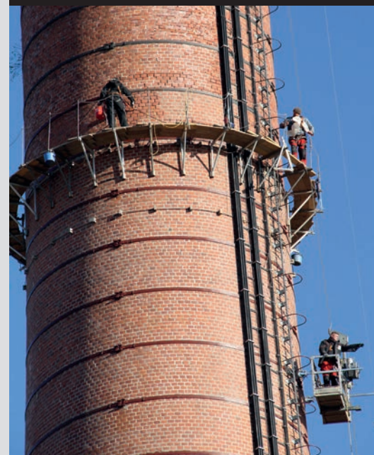
Sanierung des Industrieschornsteins auf dem Gelände der Energiefabrik Knappenrode.
