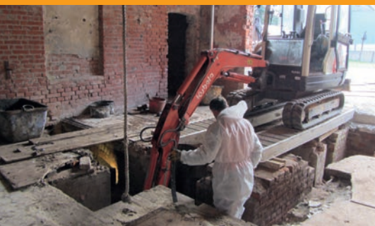
Zur Vorbereitung der Aufstellung der eingelagerten Dampfmaschine stand schweres Gerät im Maschinenhaus.
