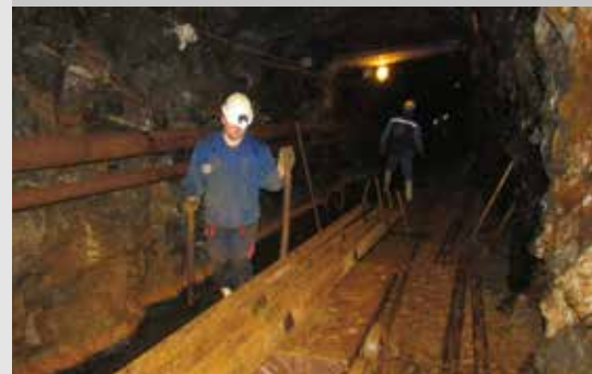
Gleisbauarbeiten auf dem Tiefen Sauberg Stolln
