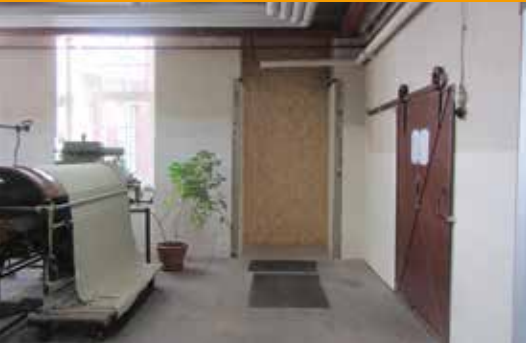
Sanierte Eingangstüren im Webereigebäude
