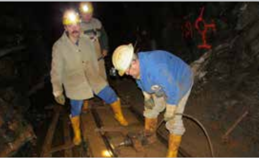
Gleisbau unter Tage
